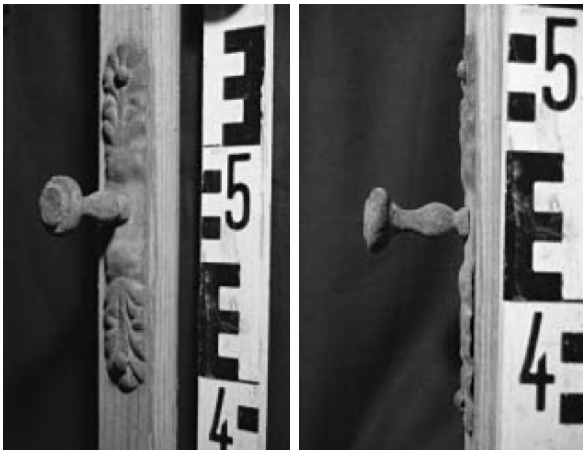
66. Kromě kresebného záznamu je relevantní formou dokumentace kování rovněž fotografie s měřítkem při vhodném nasvícení. U plochých částí kování stačí většinou jeden záběr, u komplikovanějších prvků jsou většinou vhodné alespoň dva záběry. Pravidla pro fotografování jsou stejná jako u jiných stavebních prvků. Úchopné kování barokního okna, deponované v NPÚ ÚOPŠČ v Praze. Foto: J. Veselý, 2005.
